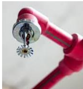
اسپرینکلر (سامانه پاششی اطفای حریق)
